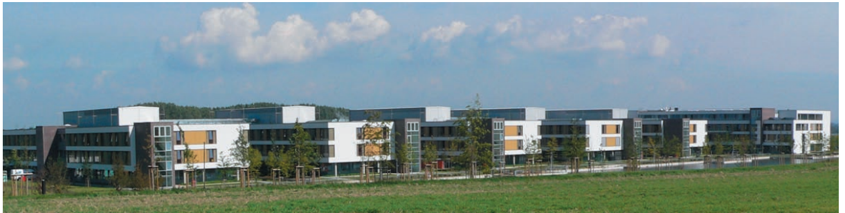
Abbildung 1: Gebäudekomplex Klinikum Minden
